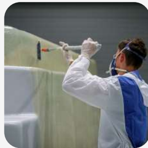
3. Auftragen eines korrosionsbeständigen Glasfasergewebes
