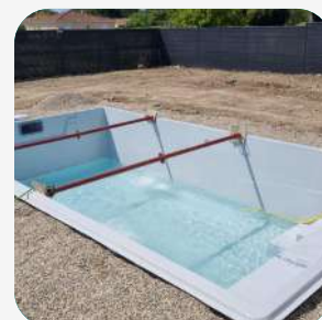
4. Beckenhinterfüllung und hydraulische Verrohrung
