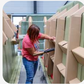
5. Anbringen vorgeformter Verstärkungen für die Stabilität des Beckens
