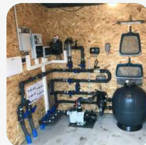
7. Installation der Filteranlage und Inbetriebnahme
