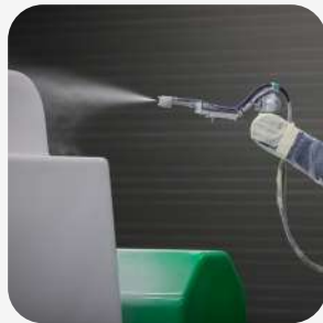
2. Auftragen des Gelcoats, der dem Becken seine Farbe verleiht
