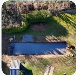
1. Erdarbeiten und Aushub
