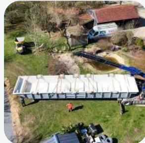
2. Lieferung und Montage des Pools
